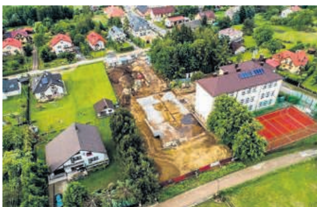
Rozbudowa SP w Mietniowie za 6,6 mln zł. Finansowe kłopoty nie zatrzymają oświatowych inwestycji w gminie Wieliczka
